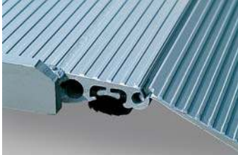
Kuva sillan alaosasta
